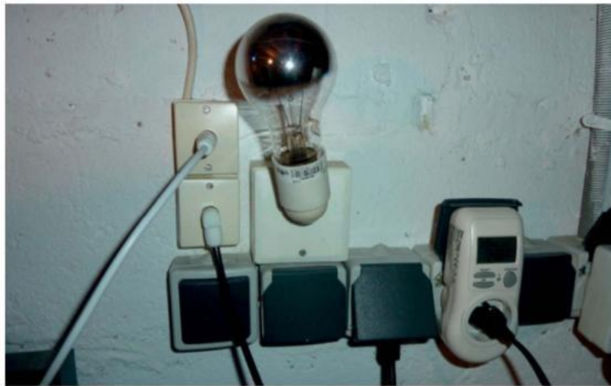
Figure 2-2. Prises murales dont une avec lampe à incandescence en série
