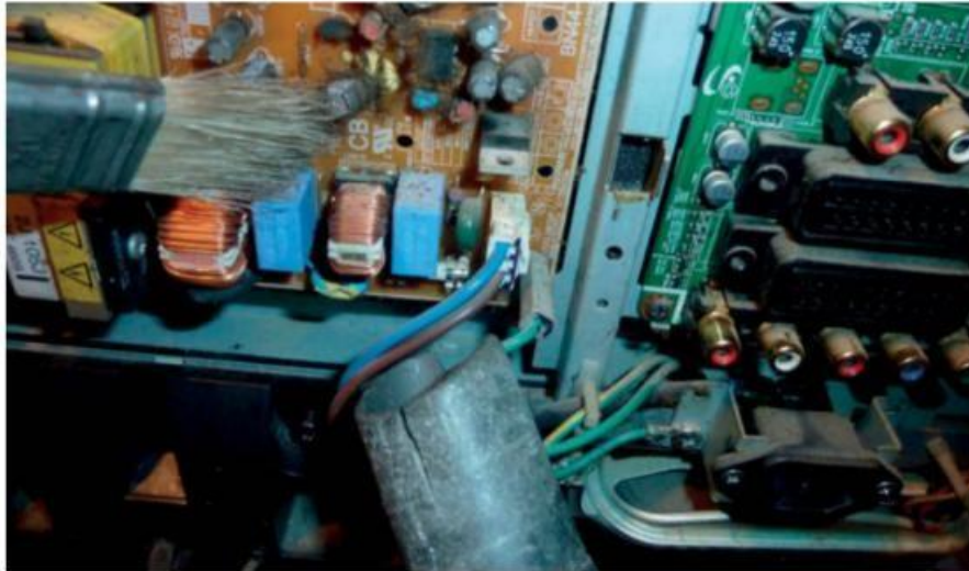
Figure 4-6. Nettoyage au pinceau et aspirateur
