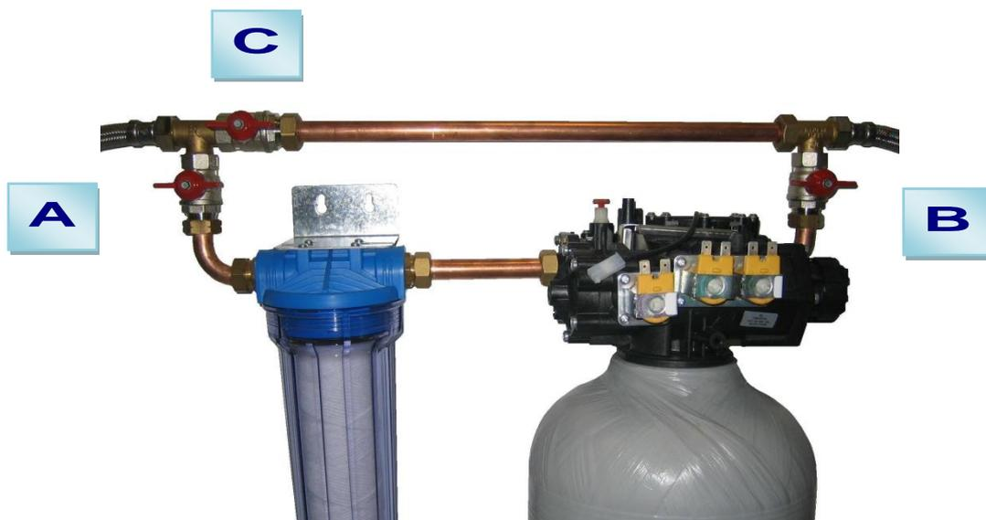
**EN ATTENDANT LA MISE EN SERVICE, LES VANNES A ET B DOIVENT ETRE FERMEES ET LA VANNE C DOIT ÊTRE OUVERTE. ATTENTION, NE PAS METTRE L'ADOUCCISSEUR EN EAU AVANT LE PASSAGE DU TECHNICIEN.**
