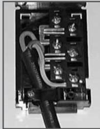
Attention : un mauvais serrage peut entraîner des risques d'échauffement dangereux au niveau du câble d'alimentation.
