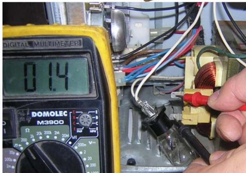
a- Mesure du primaire du transformateur. Mesurez en ohmmètre calibre cent ou deux cent ohms (100 ou 200 ohms) le primaire. Valeurs normales entre 1 et 3,5 ohms (un et trois virgule cinq ohms). Attention ! Ces valeurs sont pour des transformateurs dont le primaire doit être alimenté en deux cent trente volts, standard de distribution pour la France métropolitaine.
